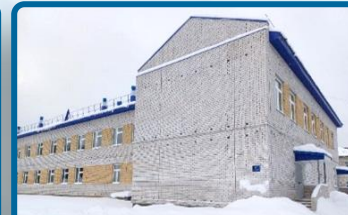
пристройка к школе п. Приводино
